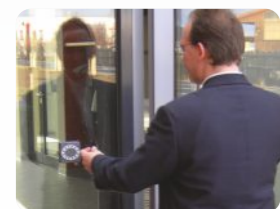
Zutrittskontrolle mit abgesetztem Leser am Webterminal. Access control with external reader at the webterminal.
