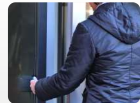
Zutrittskontrolle mit abgesetztem Datafox ZK-Leser. Access control with external Datafox access reader.
